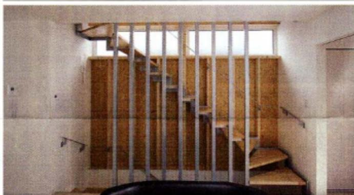
2階から上の階段は謎こみがなく、手すりも細い素材で目立たなくしている。金属の素材感だけではクール過ぎるので、木質建材と明かり取りの窓を設けて温かみも演出を入れた。
